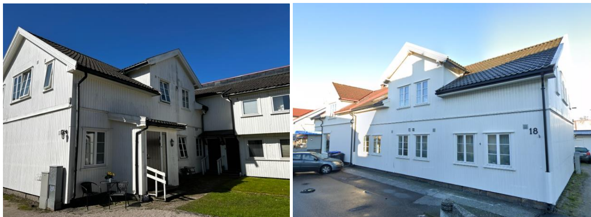
Figur 4: Seierstens gate 18a sett fra Seierstens gate og fra gårdsrommet.
