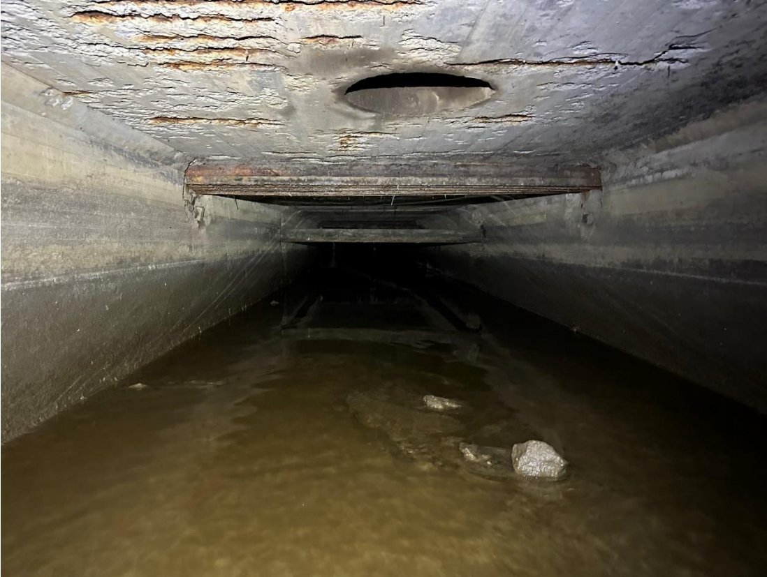
Bilde 26: Kryssende VA-anlegg
