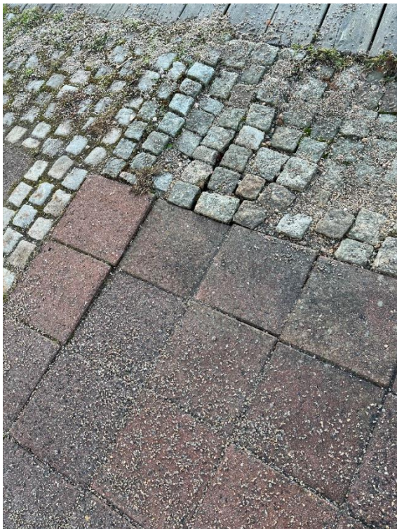
Bilde 41: På hver side av kulvert ut i Vesterelva er det setninger.
