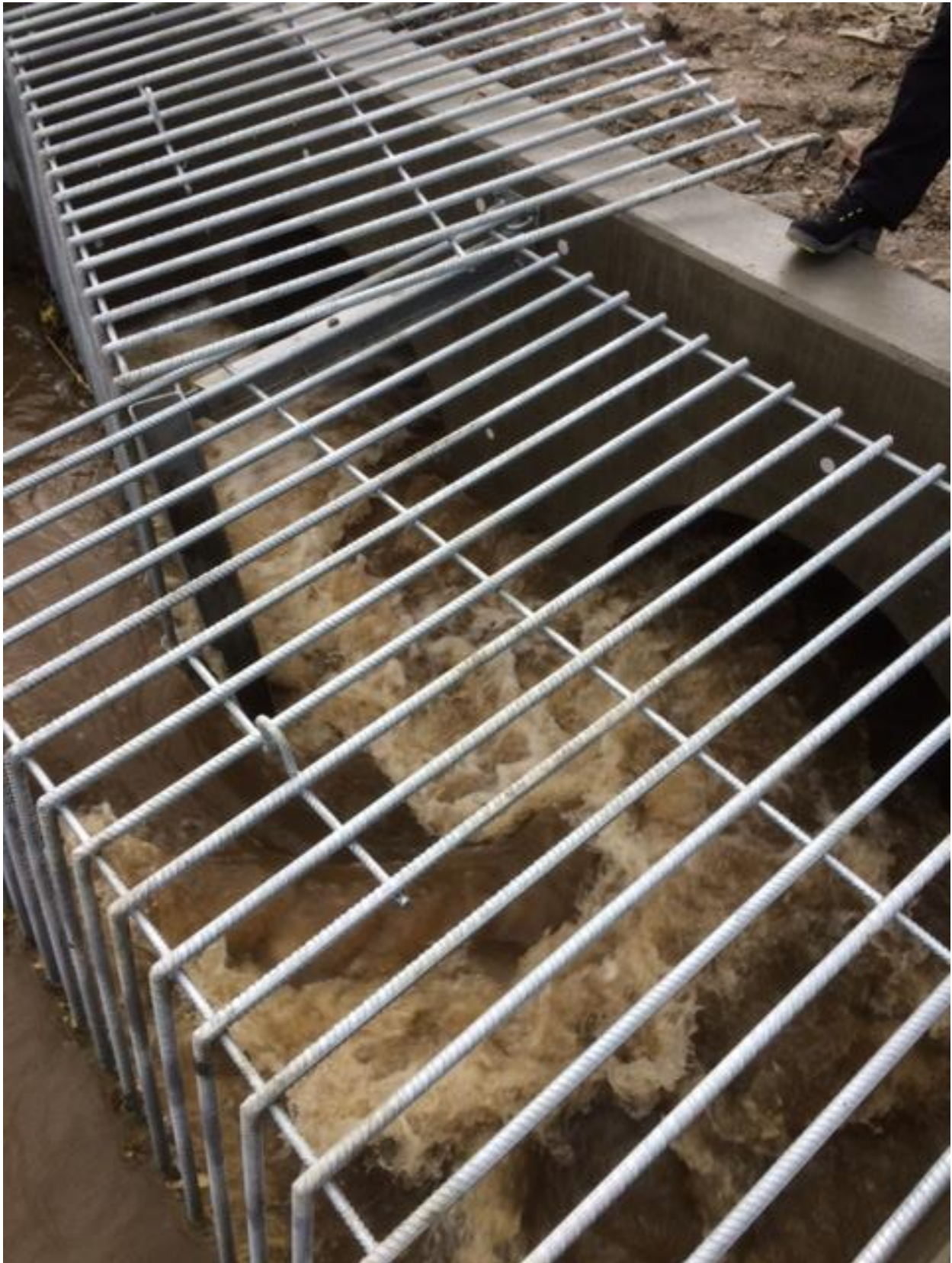
Figur 2 Inntaksrist ved flomavledningstunnel
