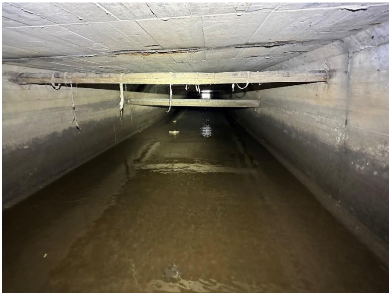
Bilde 24: Kryssende VA-anlegg
