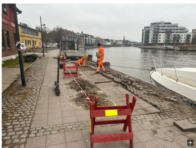
Bilde 41: På hver side av kulvert ut i Vesterelva er det setninger.
