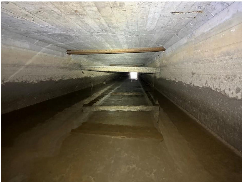
Bilde 22: Kryssende VA-anlegg
