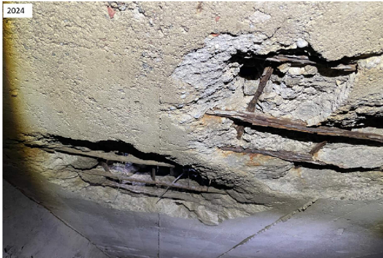
Taket i kulverten
