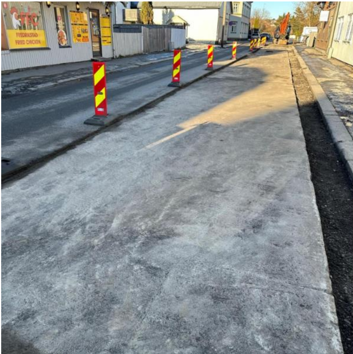
Bilde 45: Avdekket kulverttak mellom Seierstengata og Huths gate. Bilde tatt 2024-02-01.
