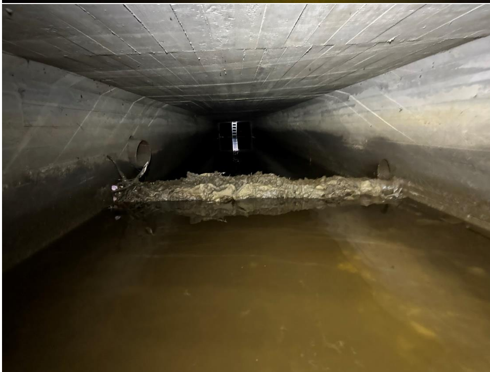
Bilde 27: Oppsamling av kvist, røtter og avløpsrester ved spillvannsledning (Øverste bilde 2020, nederste bilde 2024). Bildene viser også to kommunale overløp ved Huths gate
