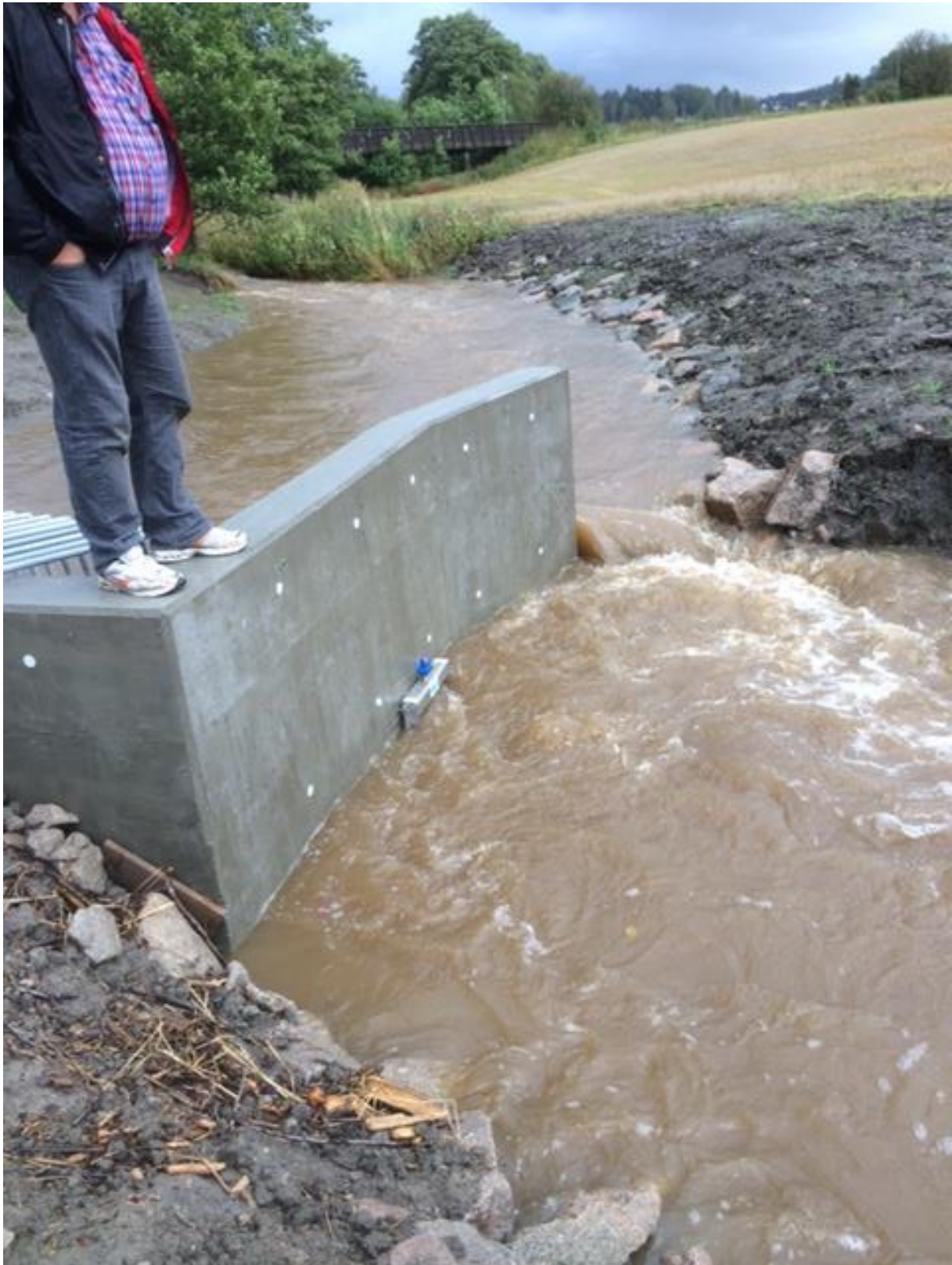
Figur 3 Inntak til flomavledningstunnel sett nedenfra. Det antas at fyllingen vil bygges opp til samme nivå som den betongvangemuren og erosjonssikres for å gi kontrollert avledning av flomvann når kapasiteten til flomavledningstunnelen nås
