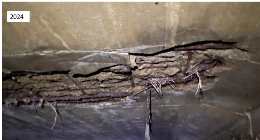
Taket i kulverten
