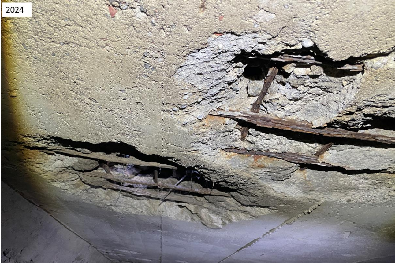
Bilde 19: Profilnummer 780 - Flere jern med stor tverrsnittsreduksjon.
