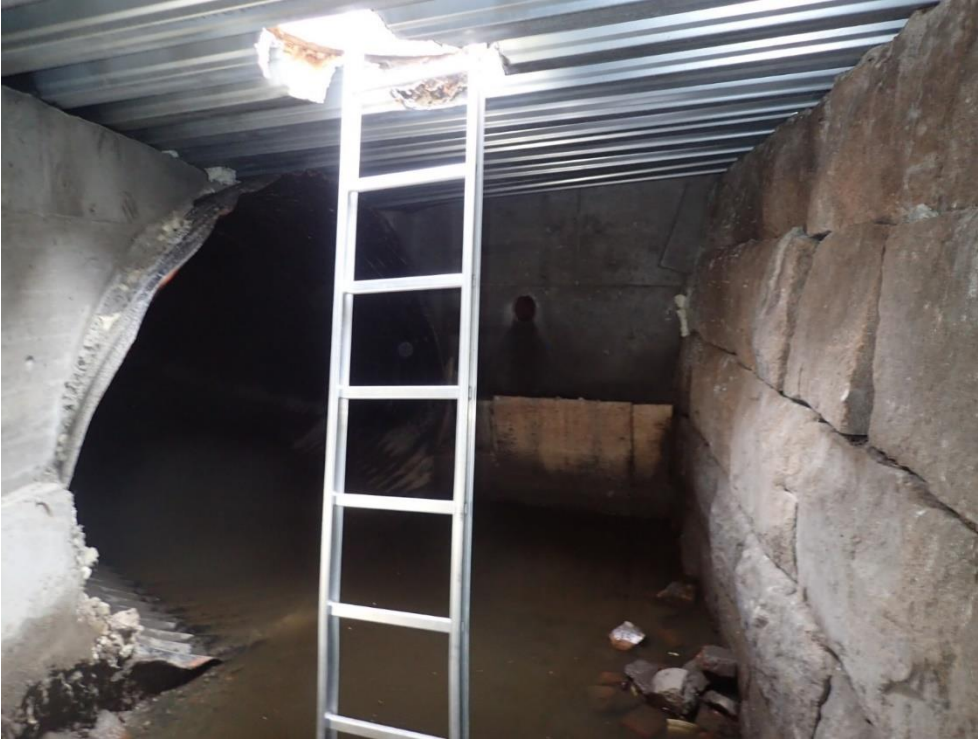
Bilde 32: Innløp i omlegging av kulvert gjennom mauprofilrør i stål
