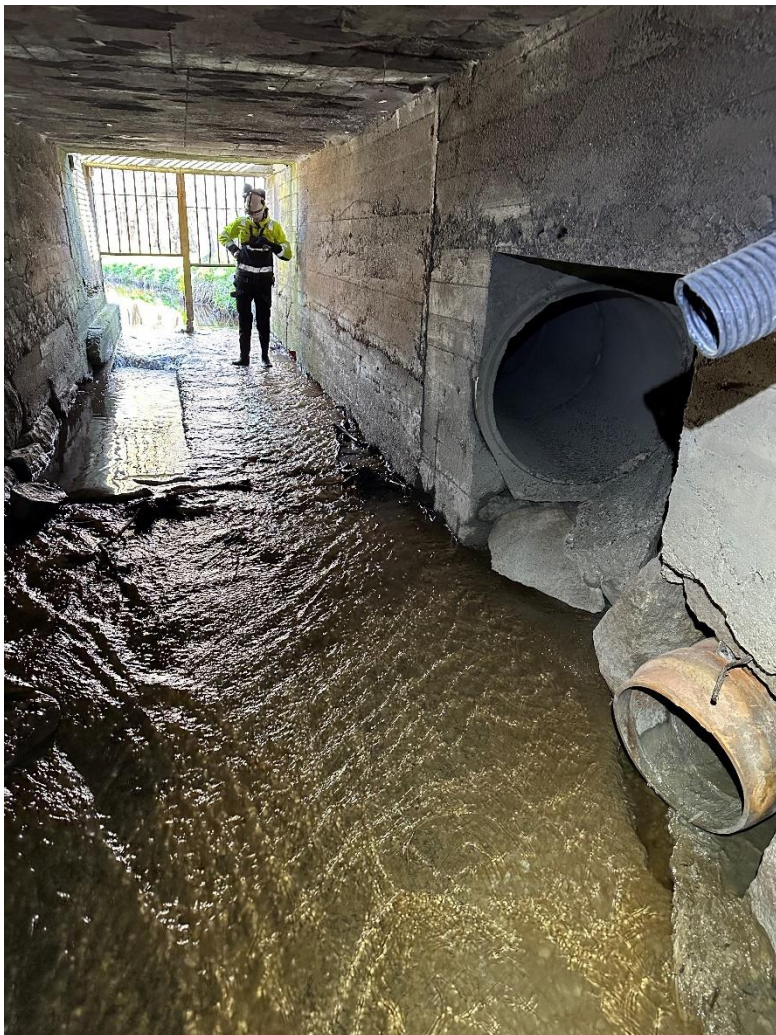
Bilde 35: Kommunalt overløp og nødoverløp
