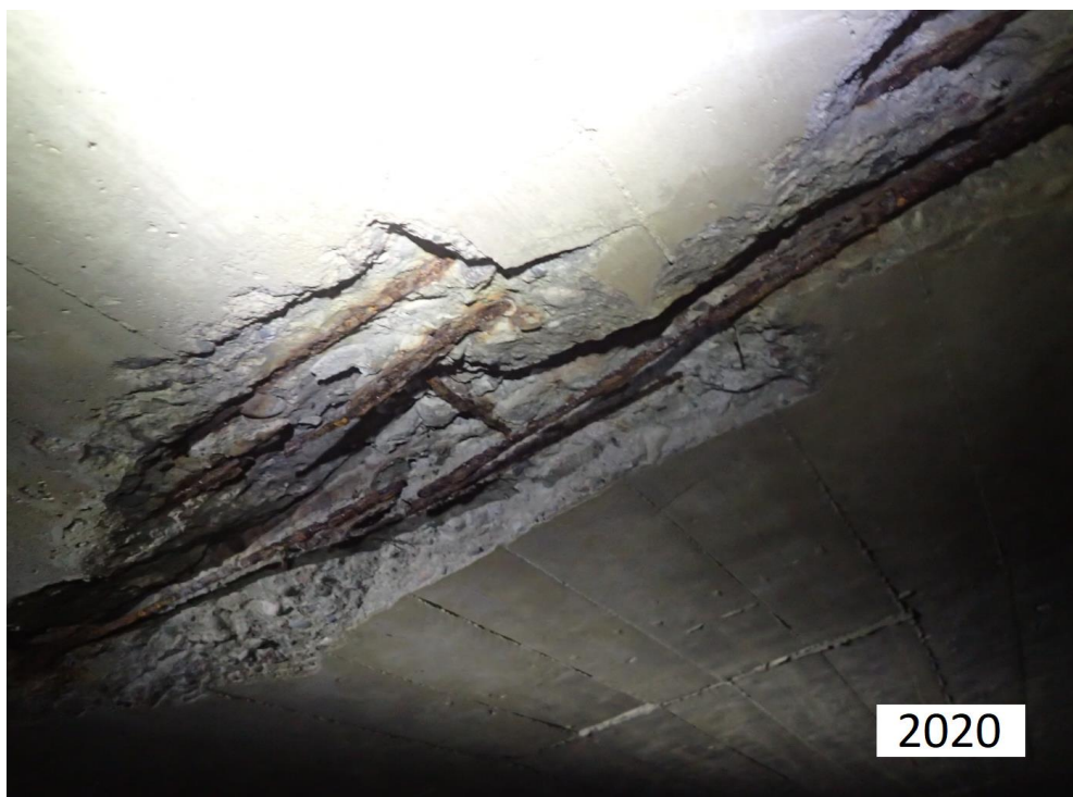
Bilde 10: Skader ved profil 326 i 2020 – økt skadeomfang sammenlignet med i 2014. Brudd i enkelte jern i motsetning til i 2014 og 2017.
